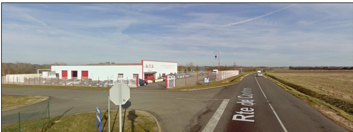
Point de vue des conducteurs dans la zone d'occurrence identifiée au niveau de l'entrée de l'entreprise A.T.S
